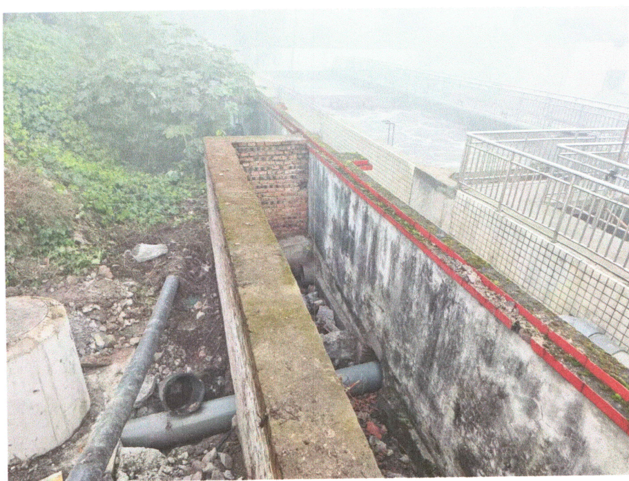
图2 管道改道照片
